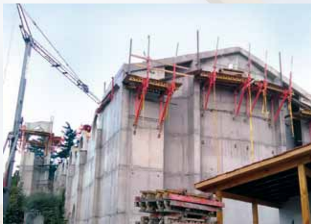
El próximo 16 de diciembre será dedicado el templo de Doñihue, el cual debió ser derrumbado tras el terremoto del 27F.
