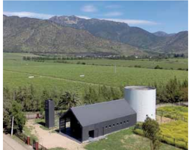
El proyecto arquitectónico de Gonzalo Mardones buscó la forma de recuperar el silo que era tan significativo para la comunidad, dejándolo como un anexo a la capilla.
