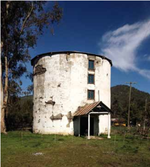
Durante décadas la comunidad utilizó este silo como capilla para reunirse a orar. El terremoto del 27F lo colapsó y no pudo ser utilizado nuevamente.
