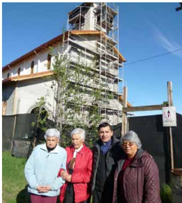
Laura y Elizarda Brown González, junto al padre Cristian Salazar y Ana Peñaloza Allendes. Atrás la parroquia de Pumanque en plena construcción.
