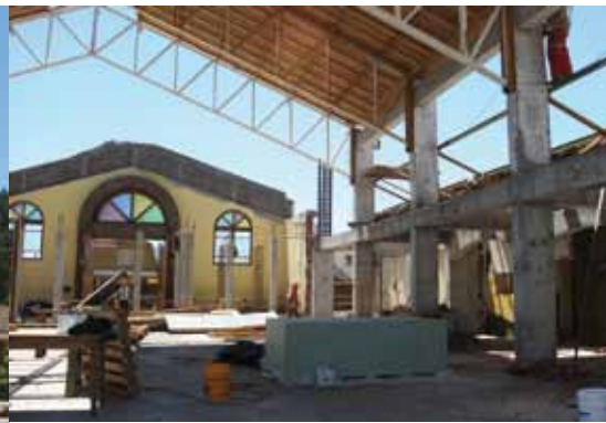
Se están ejecutando obras en la Parroquia Pichilemu.
