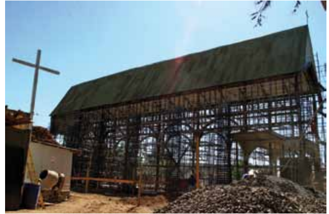
En Lolol se están ejecutando los trabajos.
